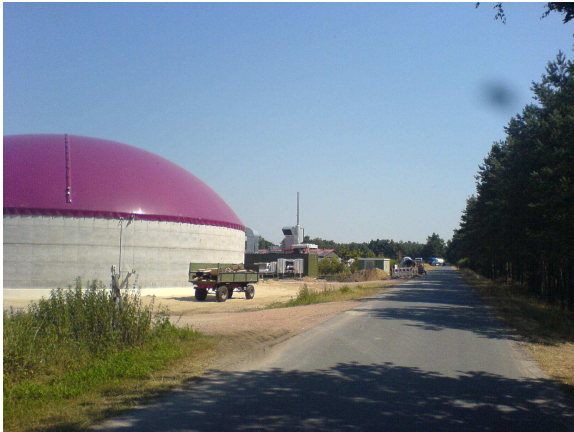
Foto 1: Wirtschaftsweg, Blick aus Ri. Südwesten
