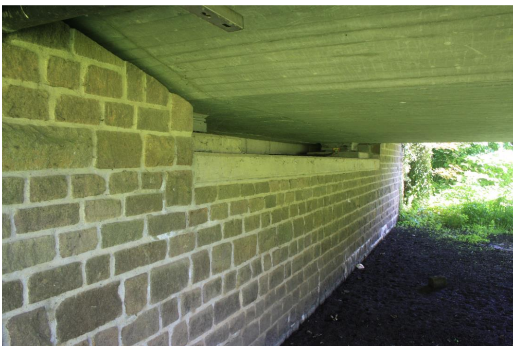
Abbildung 2-4: Östliches Widerlager der Flutbrücke
