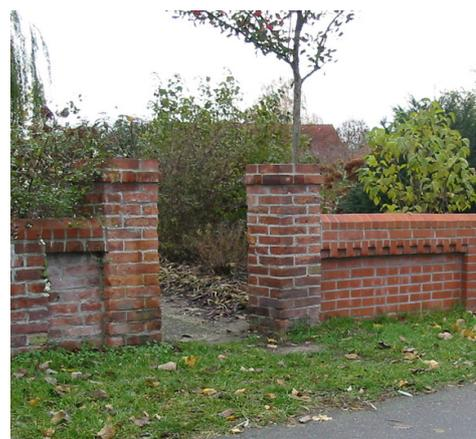
Abb.24 Backsteinmauer teilweise erneuert
