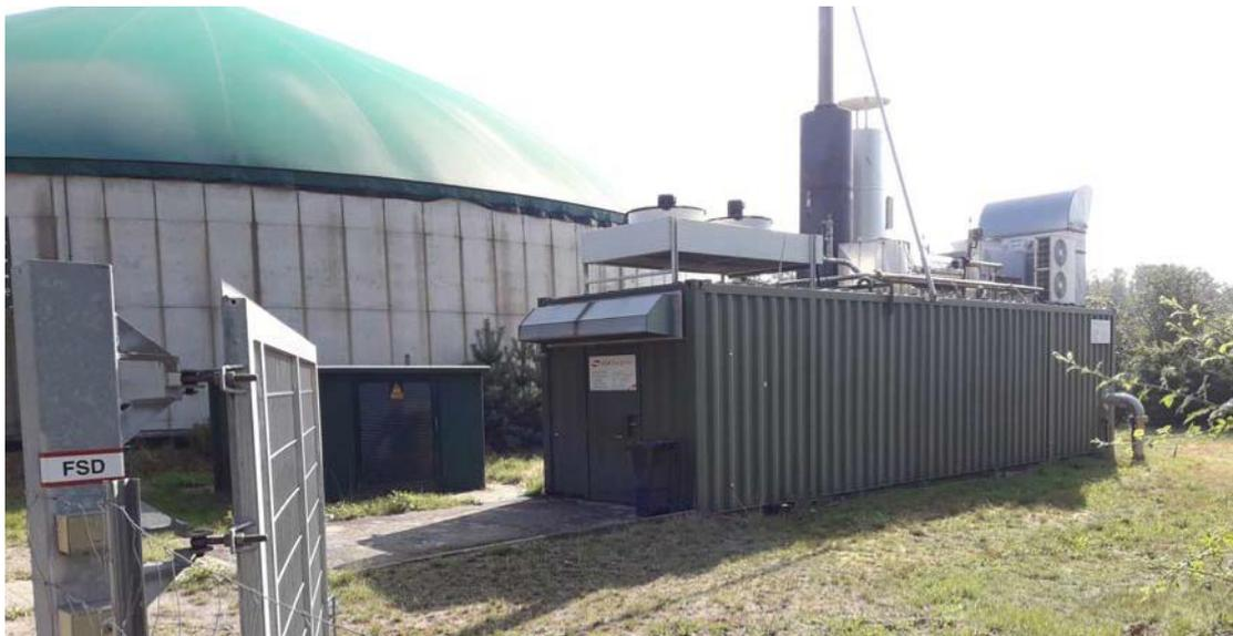
Foto: Südwestseite BHKW-Container mit „Notkühler“ und „Gemischkühler“ auf dem Dach
